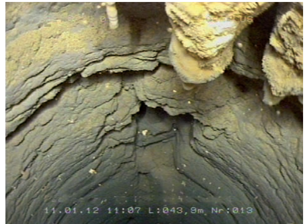
Bohrung in Fels - unverroht
